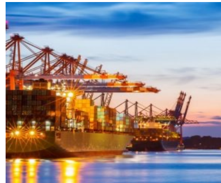
AB Maersk Vado Ligure Vado Ligure, Italia Sección Uniforme (US) 31,000 m 2
