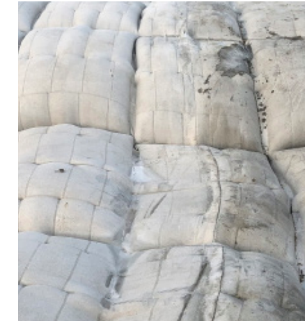
Articulación creada con estructura interna de cables
