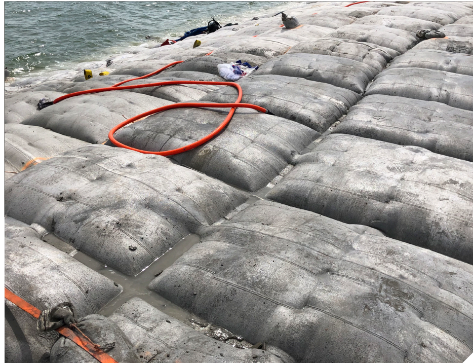
Proceso de relleno de Colchón de Concreto Bloque Articulado
