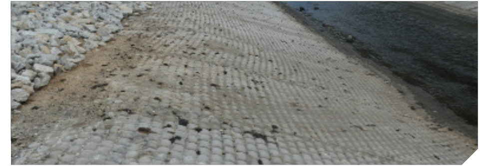
Proceso de llenado del colchón de Concreto Bloque Articulado
