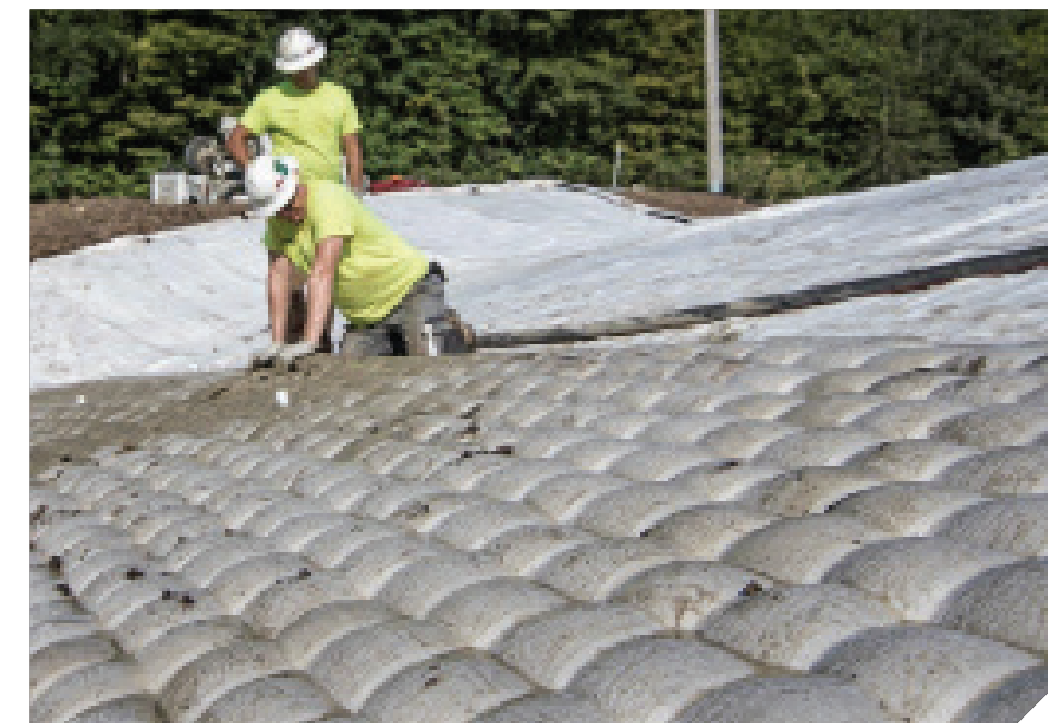
Sección Uniforme durante la instalación
