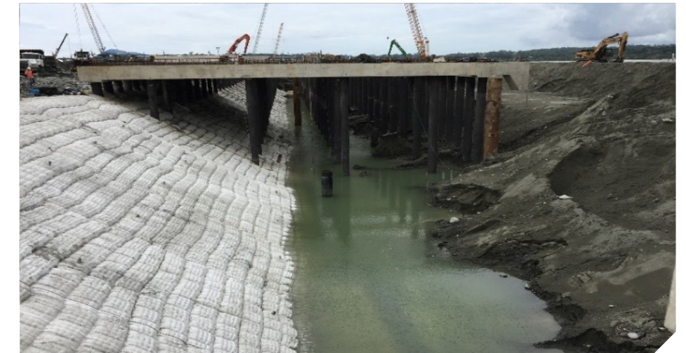
Revestimiento de bloques articulados de concreto Hydrotex
