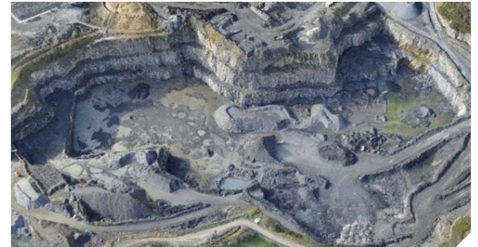
Cantera de roca típica del tipo necesario para la producción de Rip Rap
