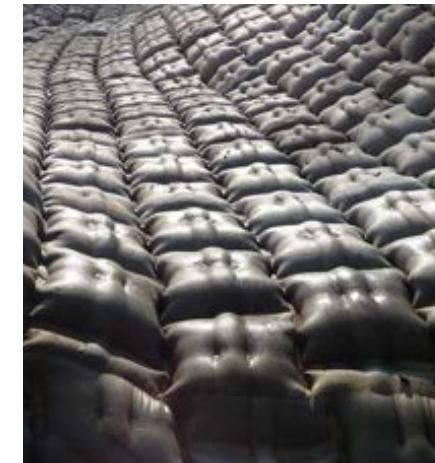
Articulación generada con una estructura interna de cables.
